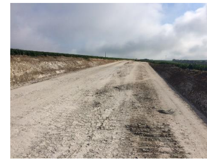
Décapage de terres arables
