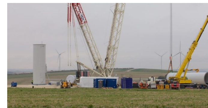
Assemblage du mat- Parc éolien des Vents de Brunelle
