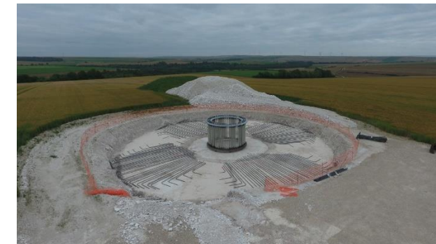
Béton de propreté, bride d'ancrage et fourreaux de réservation
