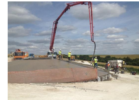
Coulage, vibration et lissage du béton
