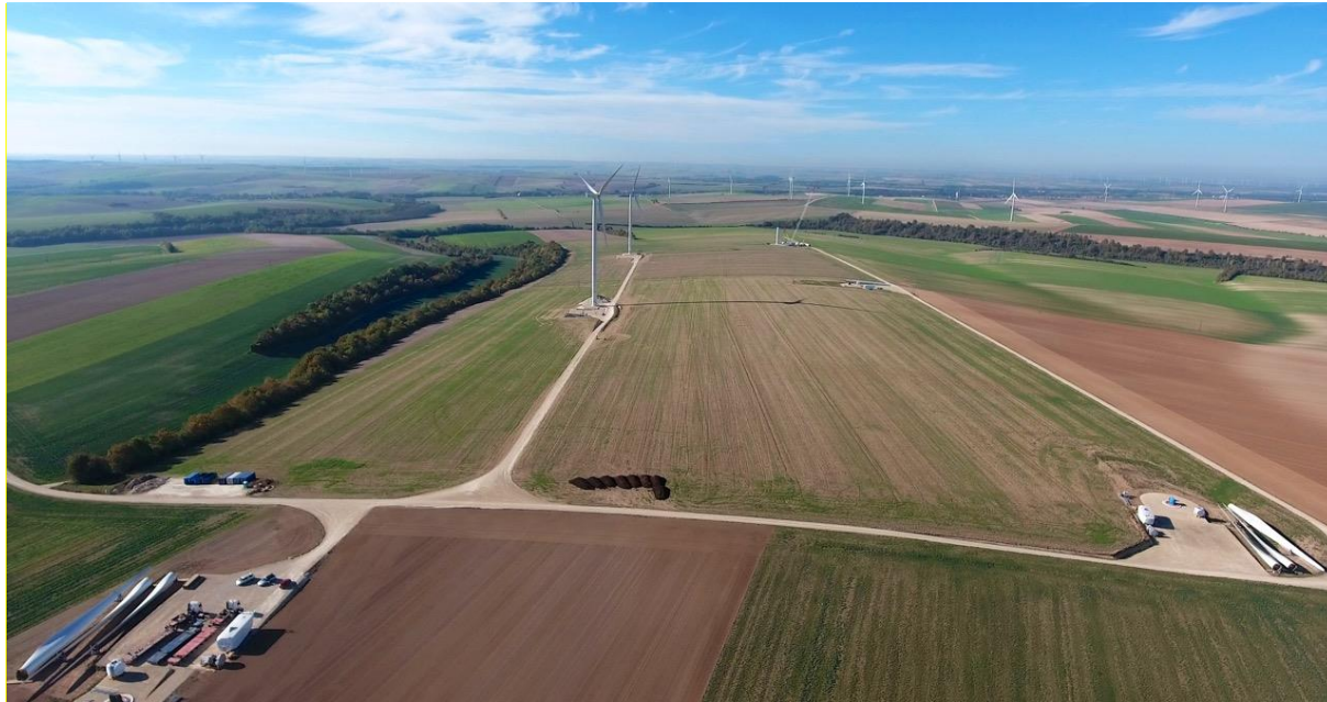
Figure 6 : Photographie du parc éolien des Vents de Brunelle en phase de construction (Source : TENERGIE)
