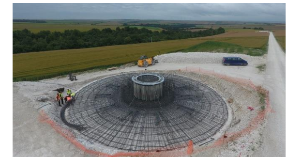
Ferraillage autour de la bride d'ancrage et coffrage
